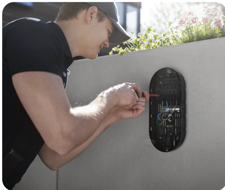
En bakplatta är förberedd för DEFA Power Up. Ta bort skyddsloket och anslut ladeenheten
