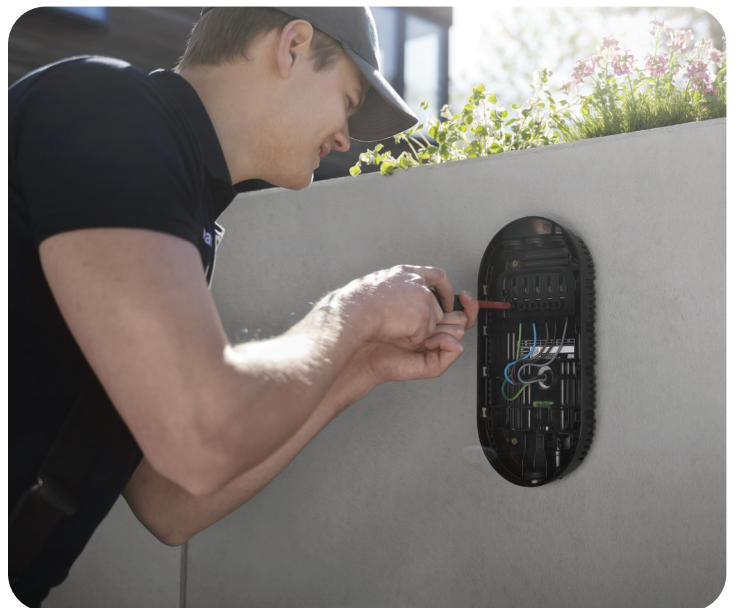
En bakplate er klargjort for DEFA Power Up. Fjern beskyttelsesdekslet og klikk på ladeenheten.
