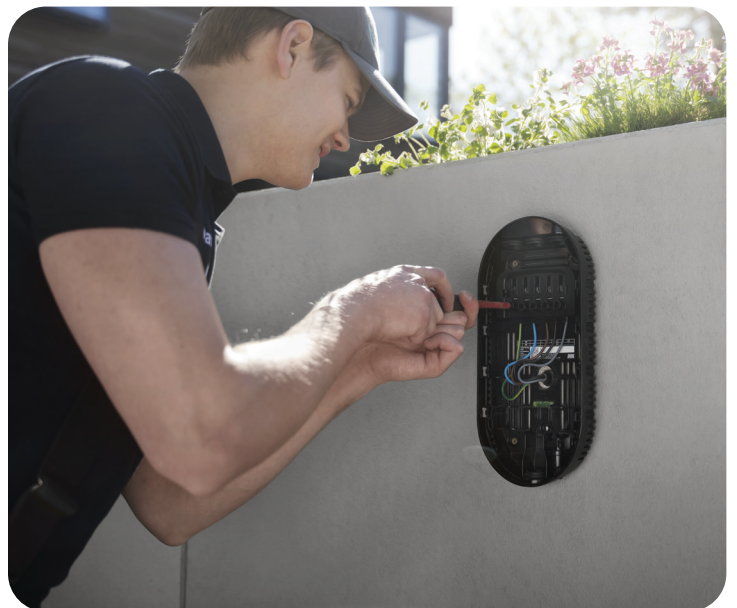
En bakplate er klargjort for DEFA Power Up. Fjern beskyttelsesdekselet og klikk på ladeenheten.
