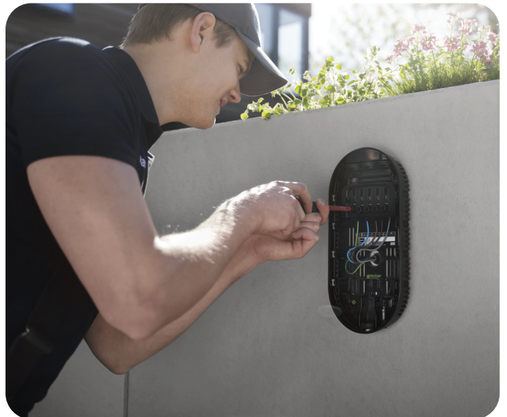
En bakplatta är förberedd för DEFA Power Up. Ta bort skyddsloket och anslut ladeenheten
