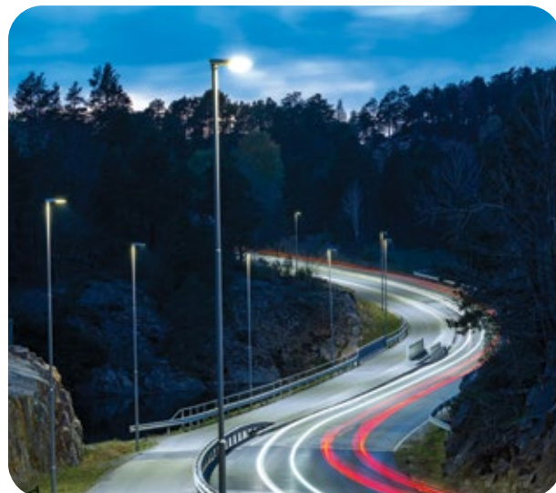
Installatör för projektet i Nesodden var Nettpartner avd Fredrikstad.
